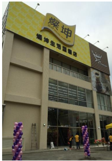
燦坤高雄華榮商場營建工程
